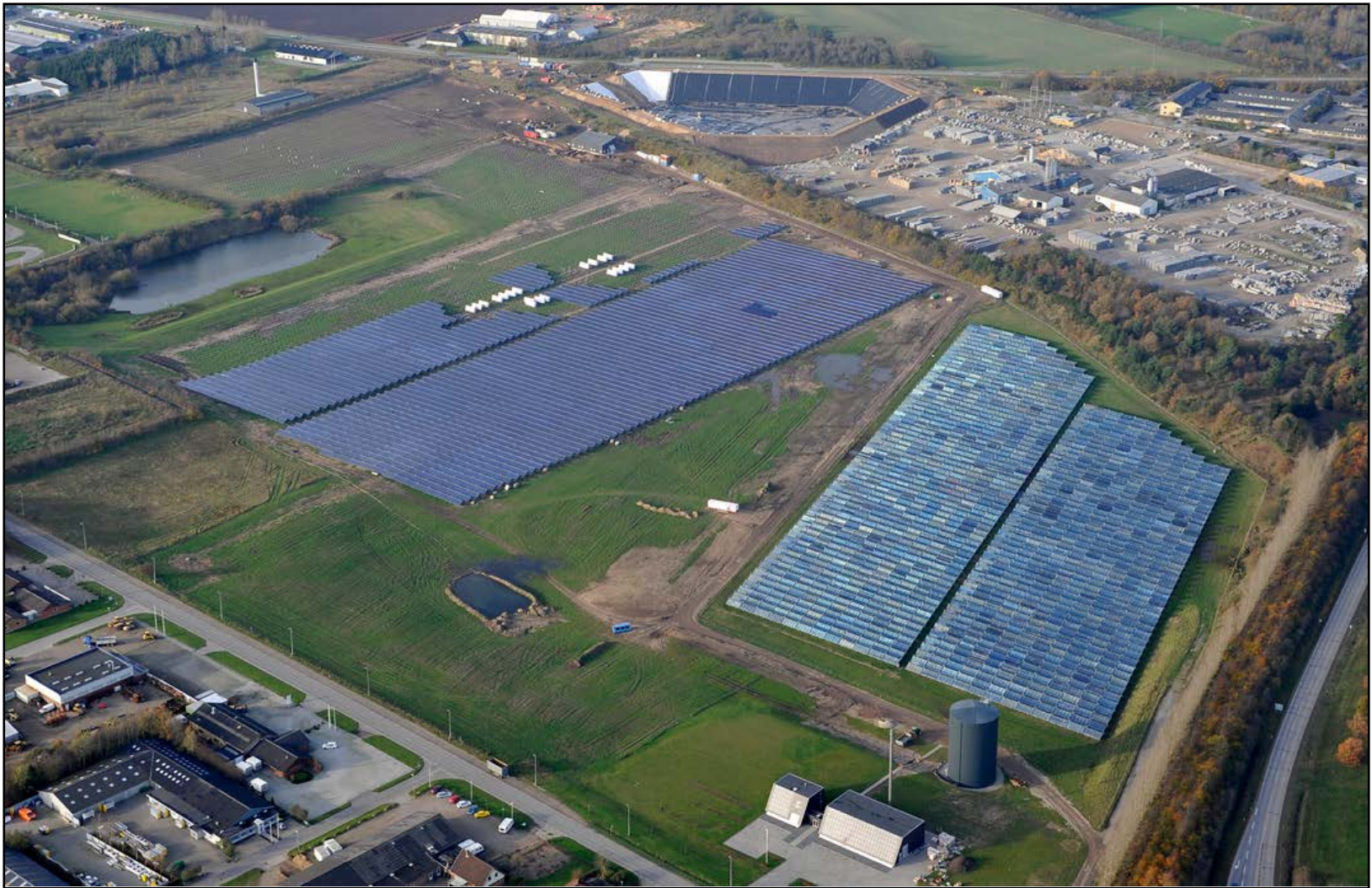
Kollektorfeld: 70.000 m 2 und Langzeitspeicher: 207.000 m 3
