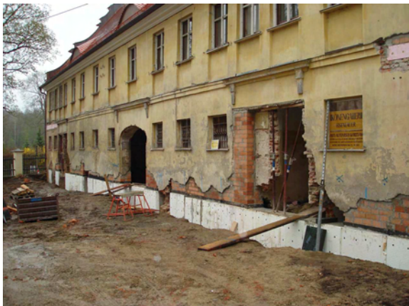
Abb. 3: „Niedere Schloss“ Beginn Sanierung Quelle: Arch. Martin Endhardt
