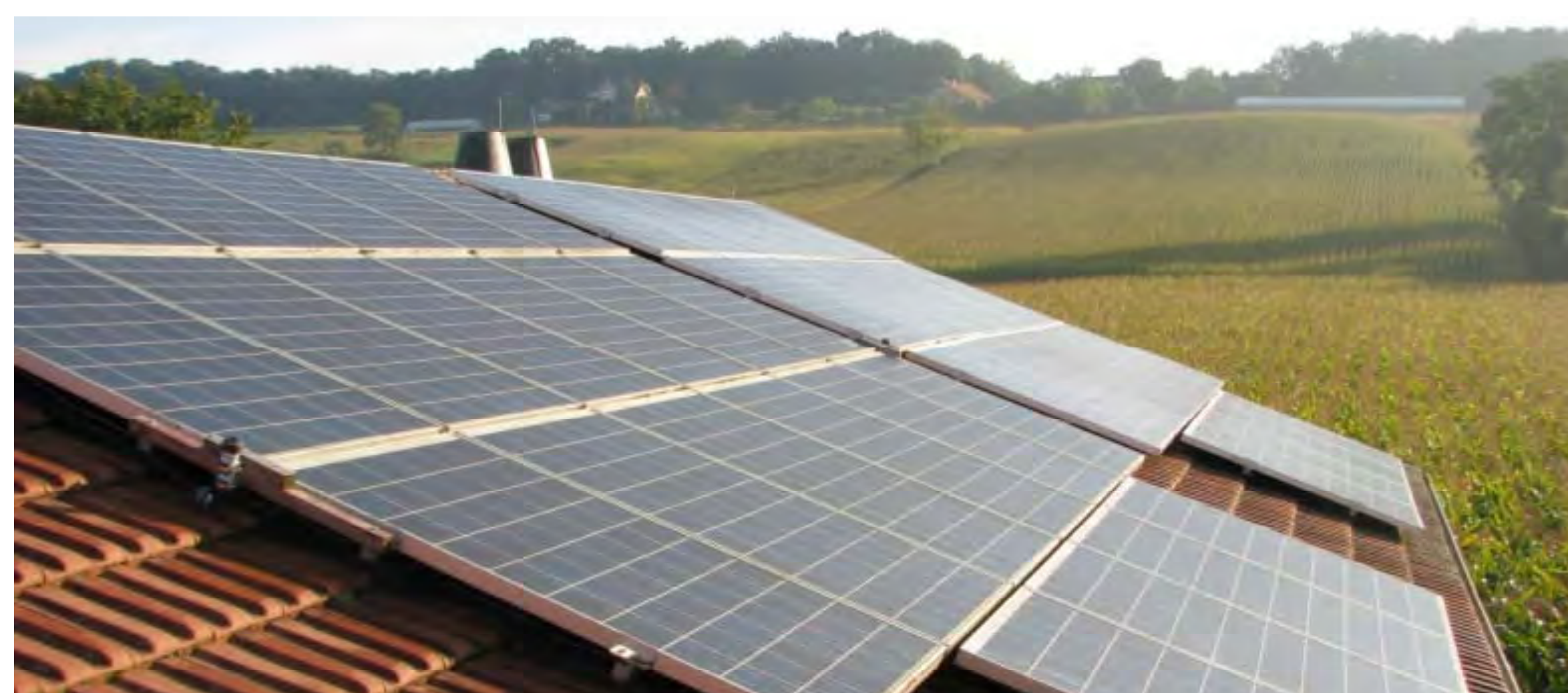
Abbildungen Versuchsaufbau: links oben: Hauswasserwerk samt Steuerung, rechts oben: Detailansicht Beregnungsanlage, unten: Gesamtansicht Photovoltaikanlagen
