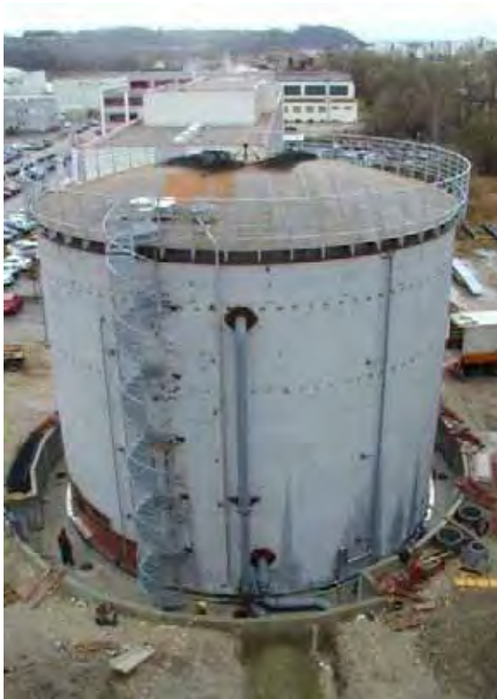
Ehemaliger Ölbehälter für Heizöl schwer
