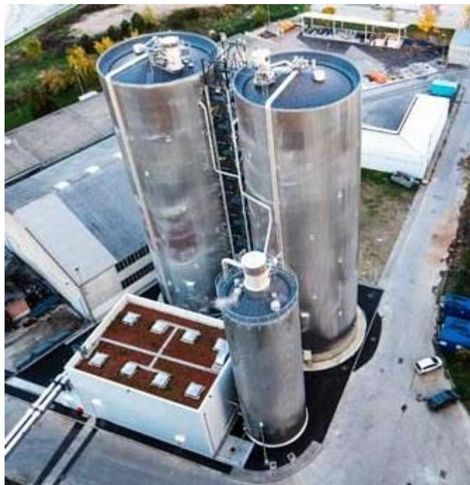
**Abbildung 33: Hochdruck-Wärmespeicher Wien [40]**
