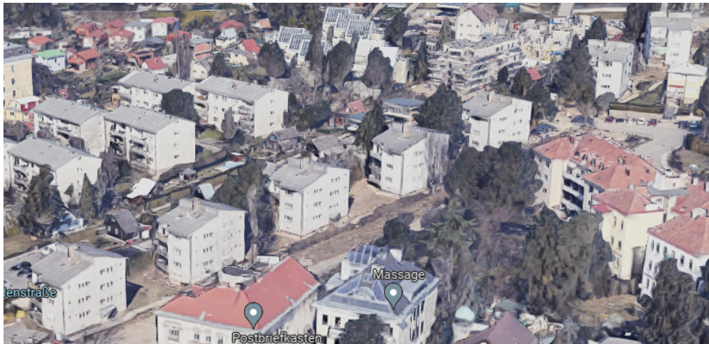
Abbildung 20. Demoprojekt in der Linzerstrasse, Wien; Lage der sieben Gebäude. Quelle: Google Maps.
