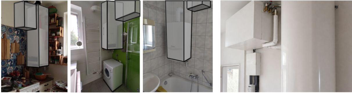
Abbildung 21: Platzangebot für Wärmepumpen in den Wohnungen (linke drei), beispielhafte Platzierung anhand eines Prototyps (rechts). Quelle: UIBK / iDM.
