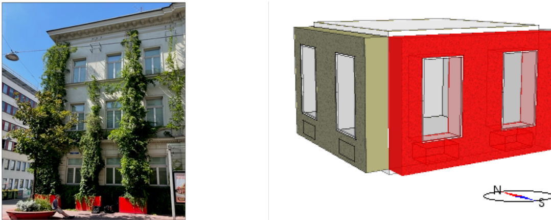
Abbildung 35: links: Frontansicht Messobjekt Amtshaus Margareten, rechts: Darstellung Simulationsmodell IDAICE (© IBO).
