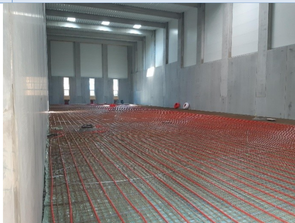
Abbildung 103: Verlegung der Bauteilaktivierung in Bodenplatte (Quelle: BG-Graspointner GmbH)
