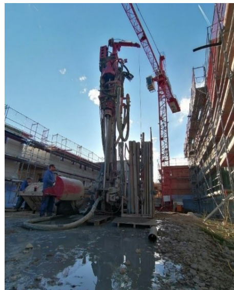
Abbildung 11: Einbringen der Erdsonden. [Quelle: AEE INTEC - 30.09.2021]
