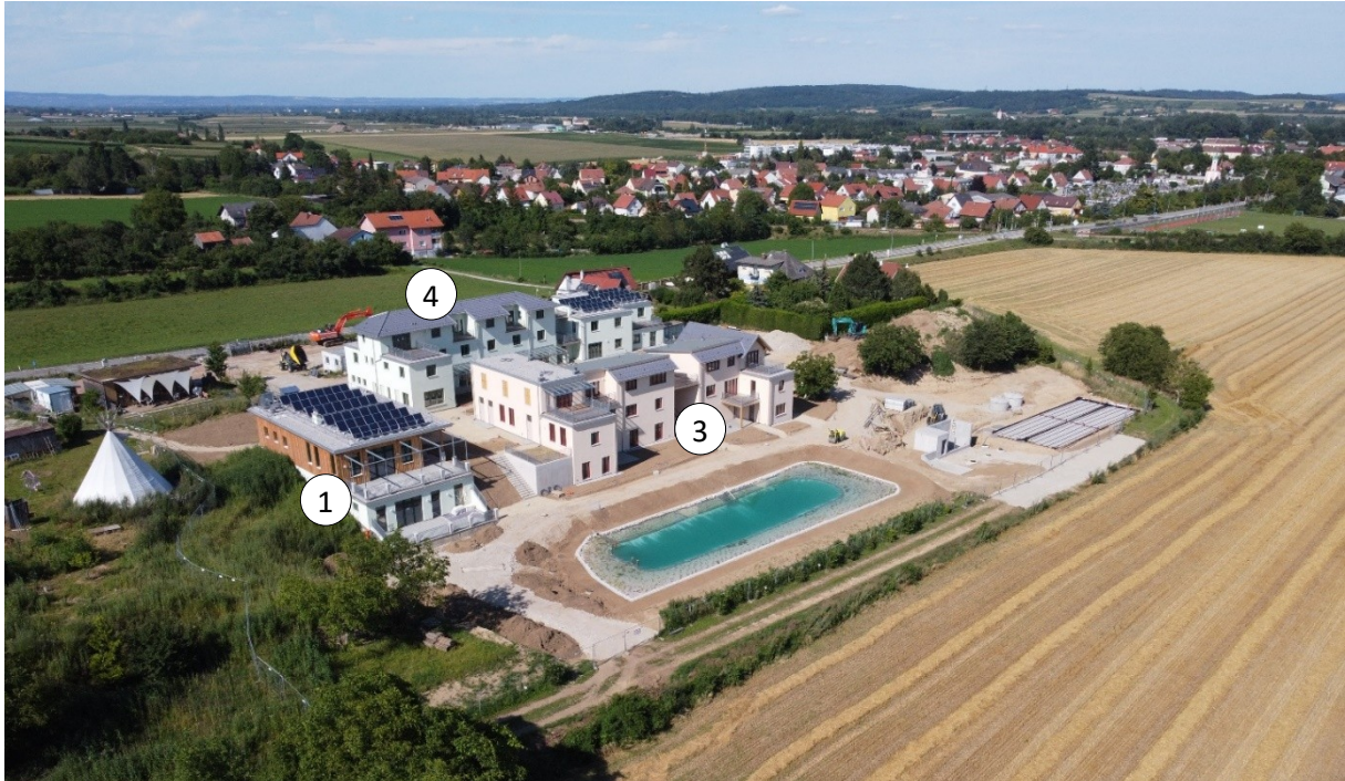
Abbildung 14: Arealansicht mit den fertiggestellten Gebäuden des ersten Bauabschnittes. Auf den Dächern der Gebäude 1 und 4 ist eine Solaranlage mit Gesamtfläche von 100m 2 installiert worden. Im Vordergrund ist ein thermisch aktivierbarer Schwimmteich situiert. [Quelle: DI Prehm]
