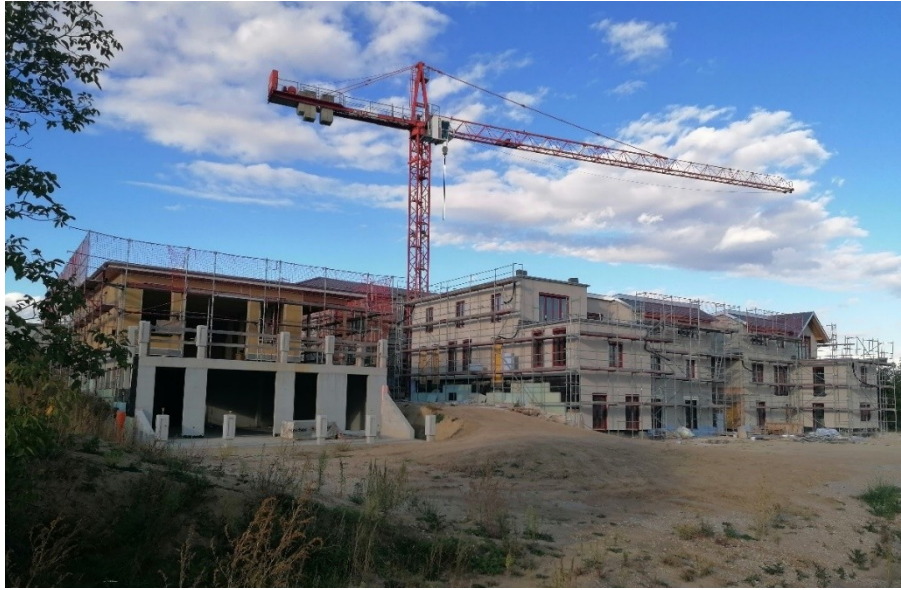
Abbildung 12: Südwestansicht des Areals mit dem Gemeinschaftshaus Objekt 1 (links) und Objekt 3 (rechts). [Quelle: AEE INTEC - 30.09.2021]
