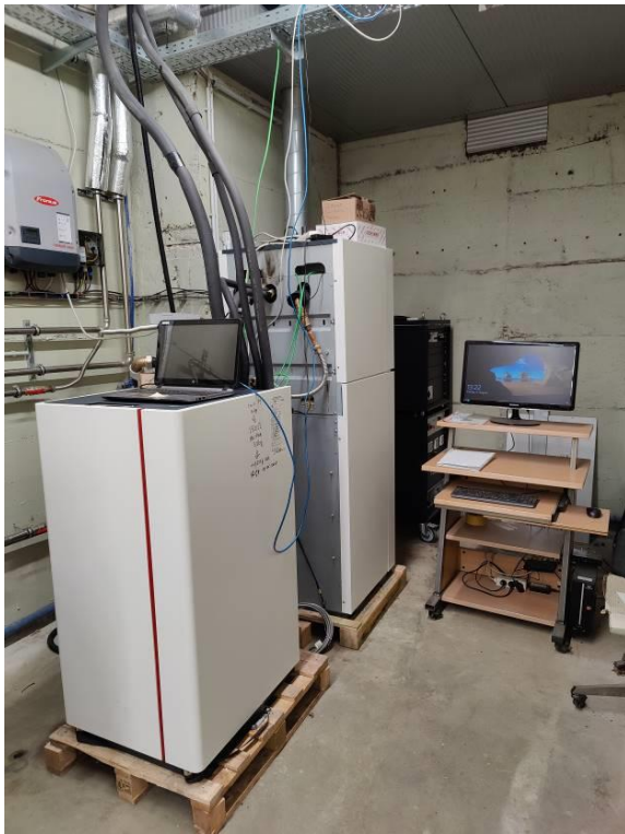
Abbildung 10: CHALLENGE Gesamtsystem bei PINK. Links: Inneneinheit und RPW-HEX Speicher. Rechts: Außeneinheit. Quelle: PINK
