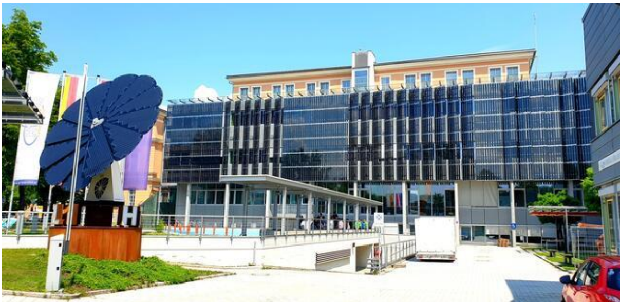
Abbildung 13 Großzügige PV-Fassade nach Umbauarbeiten (Foto: HTL1), (zum Zeitpunkt der Aufnahme wurden die Begrünungen und der Bachlauf noch nicht umgesetzt)
