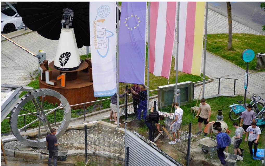
Abbildung 10 Die Schüler und Lehrer der HTL1 beim Betonieren des Bachlaufs (Foto: Irene Zluwa, 31.05.2023)
