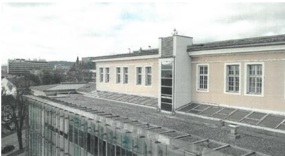
Abbildung 2 Das Kies-Flachdach der HTL (Foto: HTL1)
