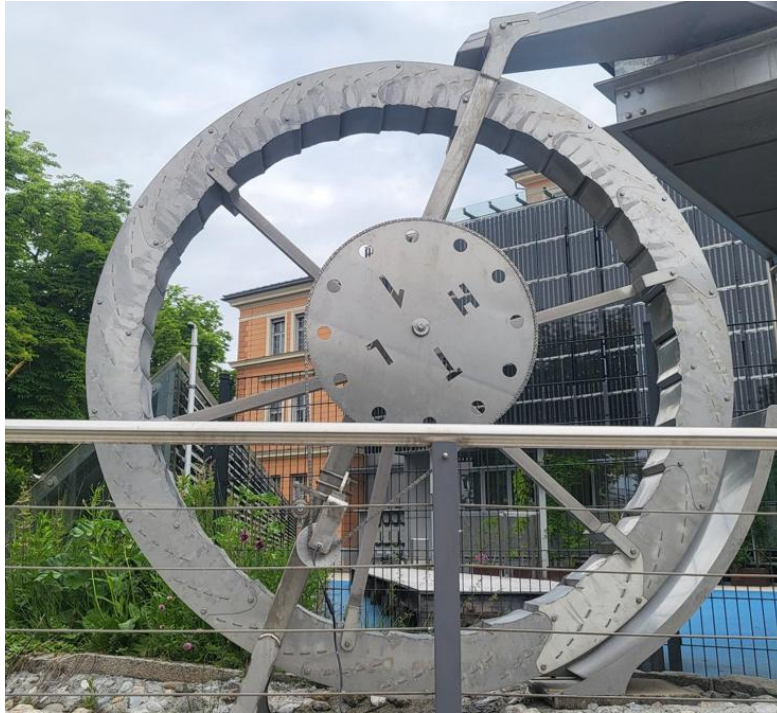
Abbildung 41 Einbau des Generators (Foto: HTL1)
