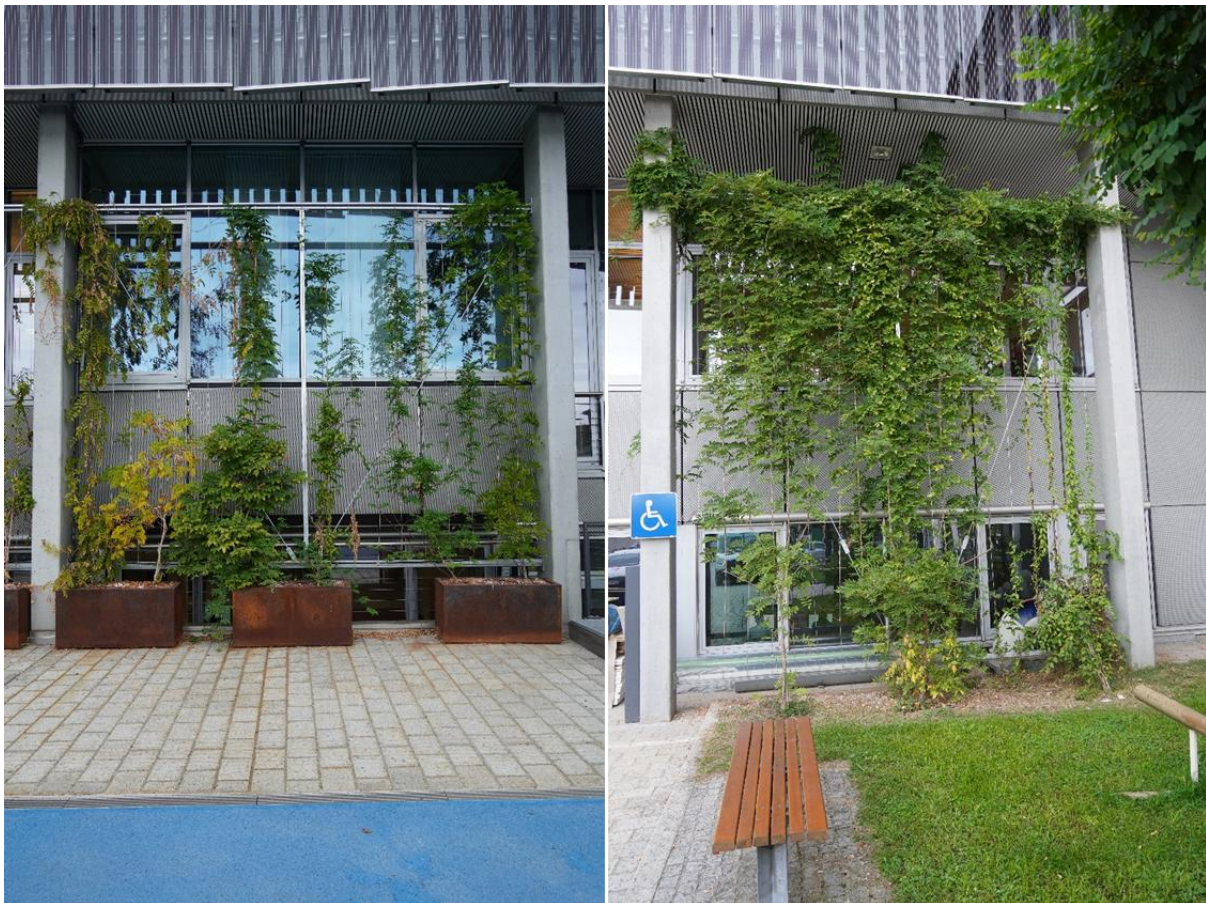
Abbildung 48 Vergleich der Pflanzenentwicklung und Deckung im Trogsystem (links) und bodengebunden (rechts). (Fotos: IPAK, Guggenberger)
