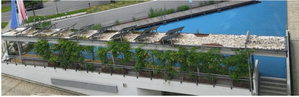
Abbildung 9 Abbildung der Pergola mit Fassadenbegrünung, künstlichem Bachlauf und PV-Modulen (Foto: HTL1)
