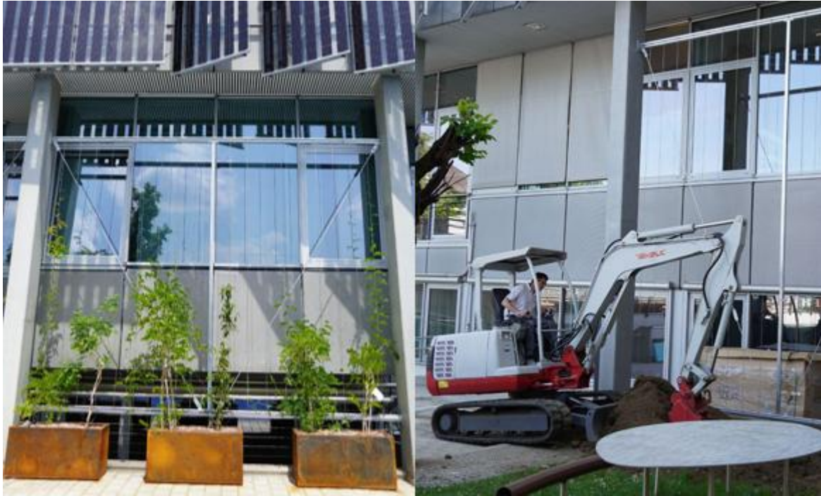
Abbildung 14 Tröge mit Kletterpflanzen an Rankseilen unter der PV-Fassade und Aushebung der Pflanzengrube für die bodengebundene Fassadenbegrünung (Foto: Zluwa, GRÜNSTATTGRAU)
