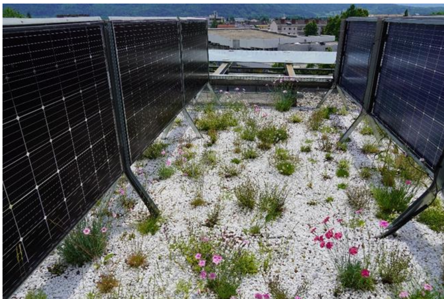
Abbildung 20 Vertikales Bifaziales PV-Gründachsystem mit silberlaubiger Unterpflanzung und weißem Kies. (Foto: Zluwa, GRÜNSTATTGRAU)
