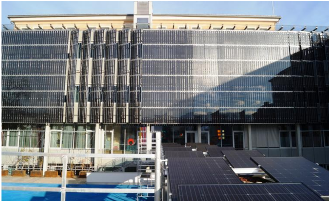
Abbildung 46 PV-Fassade (Foto: HTL1)
