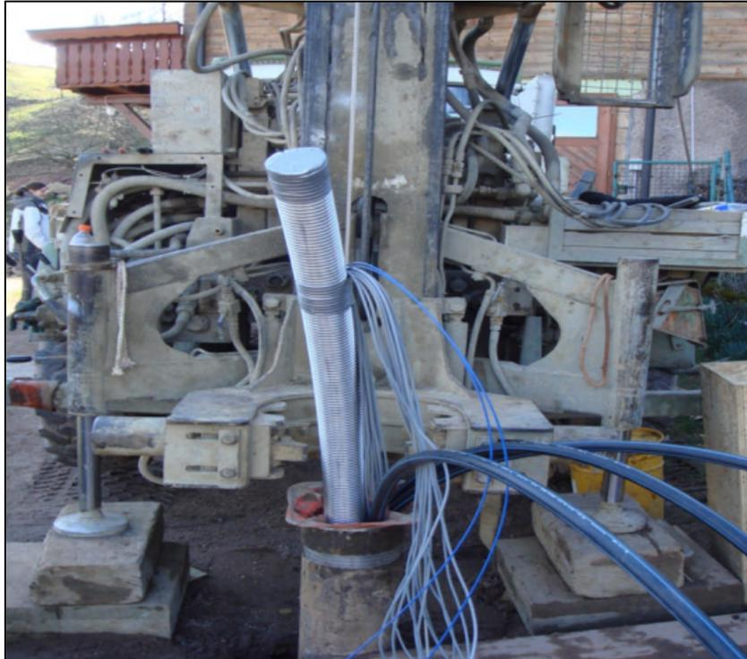
Abbildung 33: Oberes Ende des Erdwärmerohrs nach Einbringen in das Bohrloch (Kruse et al., 2011)
