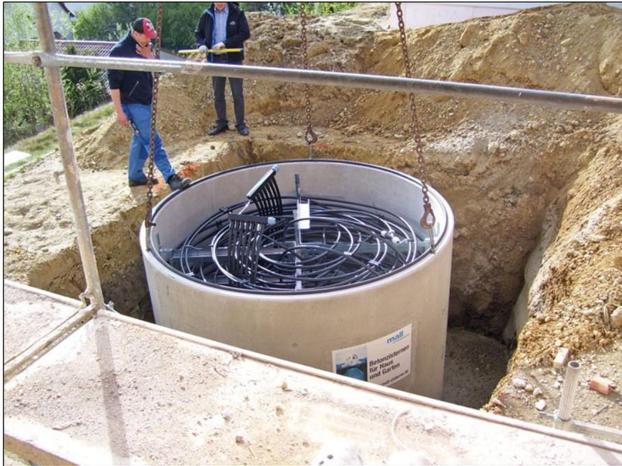
Abbildung 22: Betonzisterne (d = 3,2 m, h = 3,3 m) wird mittels Autokran in die fertige Grube gehoben (Bick, 2017; IKZ Haustechnik, 2017)
