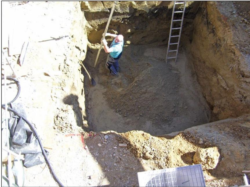
Abbildung 20: Das Ausheben der Grube für den 10 m<sup>3</sup> fassenden Eisspeicher im oberbayrischen Landshut. (Bick, 2017; IKZ Haustechnik, 2017)
