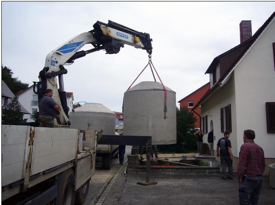
Abbildung 21: Einheben einer Betonzisterne / des Eisspeichers mit dem Autokran (hausinfo, 2022) (Isocal, 2022)
