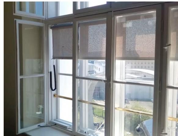
Abbildung 8: Kettenantrieb WMX 804 im eingebauten Zustand (links), unteres Rollo mit appliziertem mitfahrendem Oberflächentempersensor an Kabelkette (rechts)
