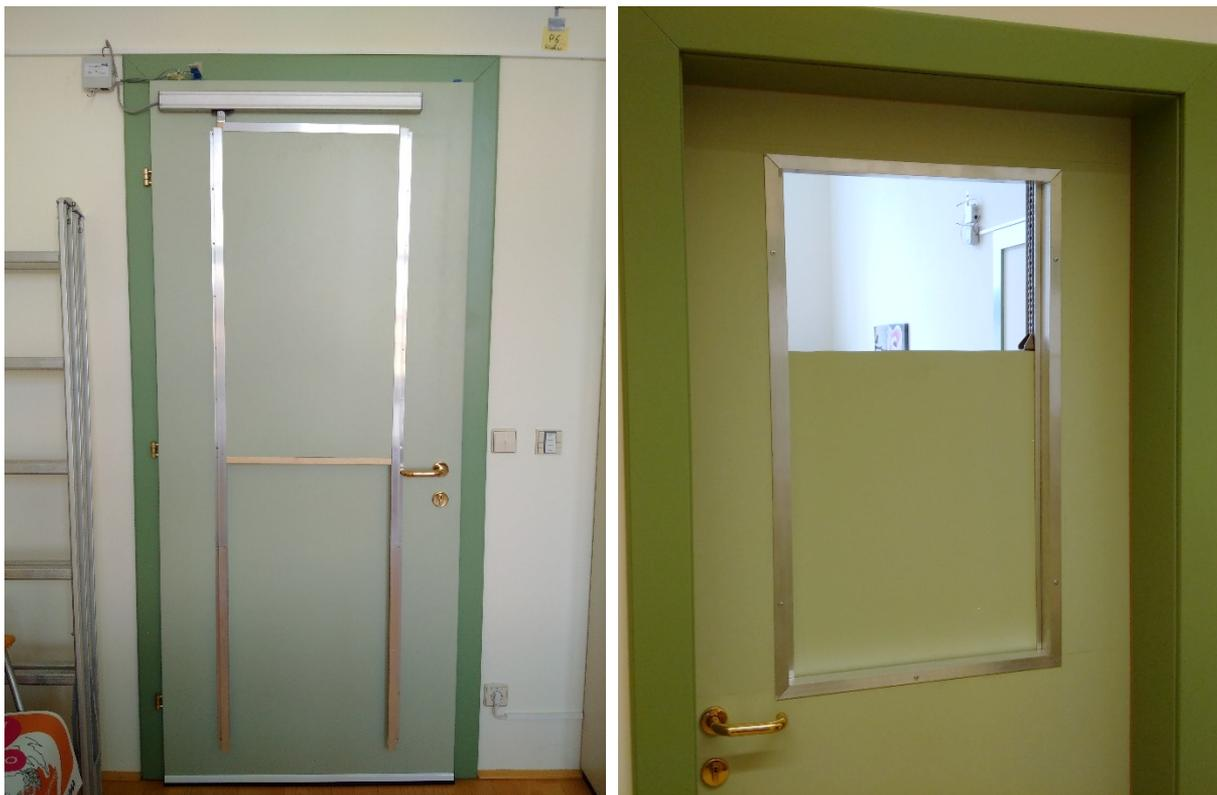
Abbildung 9: Adaptiertes Türblatt des Testraumes mit Überströmöffnung von innen (links) und außen (rechts) betrachtet
