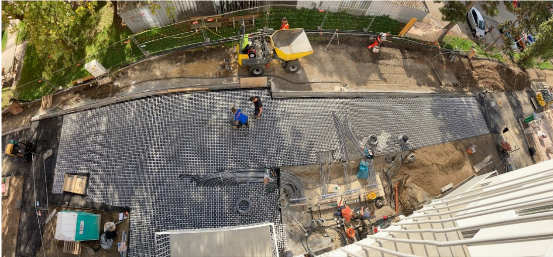
Abbildung 2: Errichtung des Asphaltkollektors in der Käthe-Dorsch-Gasse 17, 1140 Wien (Bildnachweis: AIT)
