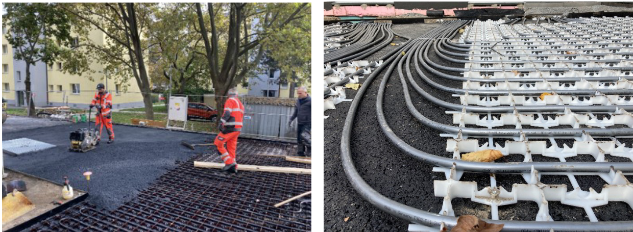
Abbildung 14: Der Asphaltkollektor während der Verlegearbeiten (links) und Detailaufnahme des Trärgitters aus Kunststoff mit den geklemmten Rohren. (Bildnachweis: AIT)
