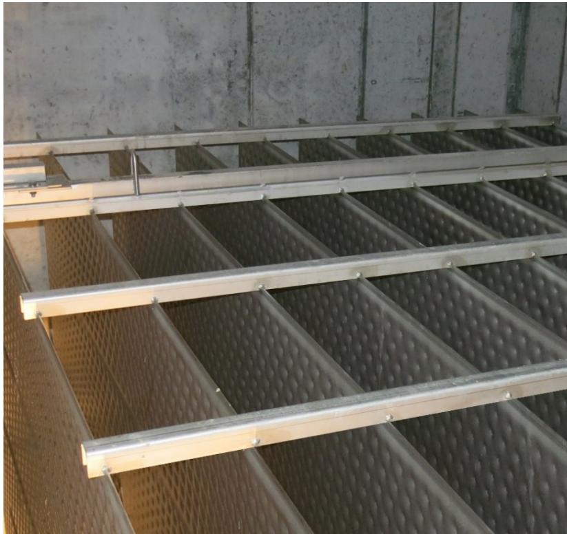
Abbildung 11: Plattenwärmetauscher im Schacht der Abwasser-Wärmerückgewinnungsanlage (Bildnachweis: Schöberl & Pöll GmbH)
