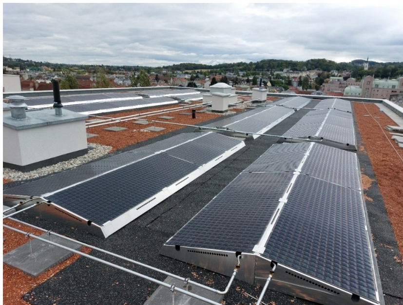
Abbildung 13: Unverglaste selektiv beschichtete Solarabsorber (Bildnachweis: Schöberl & Pöll GmbH)
