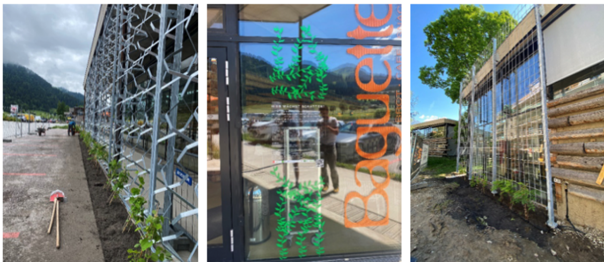
Abbildung 10: Detailaufnahmen direkt nach der Umsetzung des Demo-Objekt in SÖLL | TIROL. ©BOKU-IBLB, 2025.
