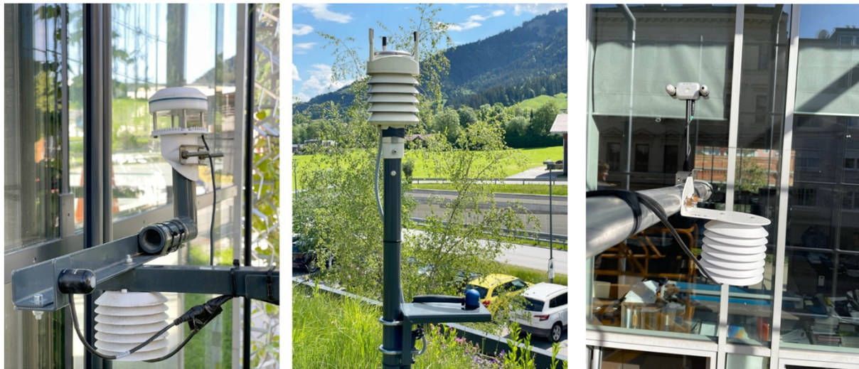
Abbildung 18: Stationäre Messeinheit SÖLL | TIROL, links: Messeinheit hinter der Begrünung (Strahlungssensor, Tair/rhum Sensor), mitte: Klimastation am Dach für Referenzwerte (Vaisala Wetterstation und Strahlungssensor), WIEN | KREUZGASSE rechts: NetRadiometer und Tair/rhum Sensor. ©BOKU-IBLB, 2025.
