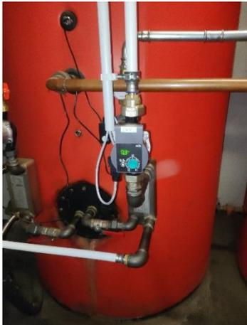
Die Wärmemengen in diesem geschlossenen Wasserkreislauf werden mit dem Durchflussmesser V5 in dazugehöriger Kombination mit den Temperaturfühlern T9, T10, T11, T12, T13 und T14 gebildet (siehe Abbildung 40).
