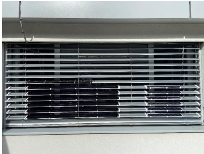
Abbildung 23: Fenster des HELLA InnovationLab mit integrierten PV-Modulen
