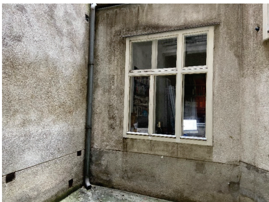
Abbildung 36: Fassade für In-Situ-Test, 1010 Wien, Parisergasse
