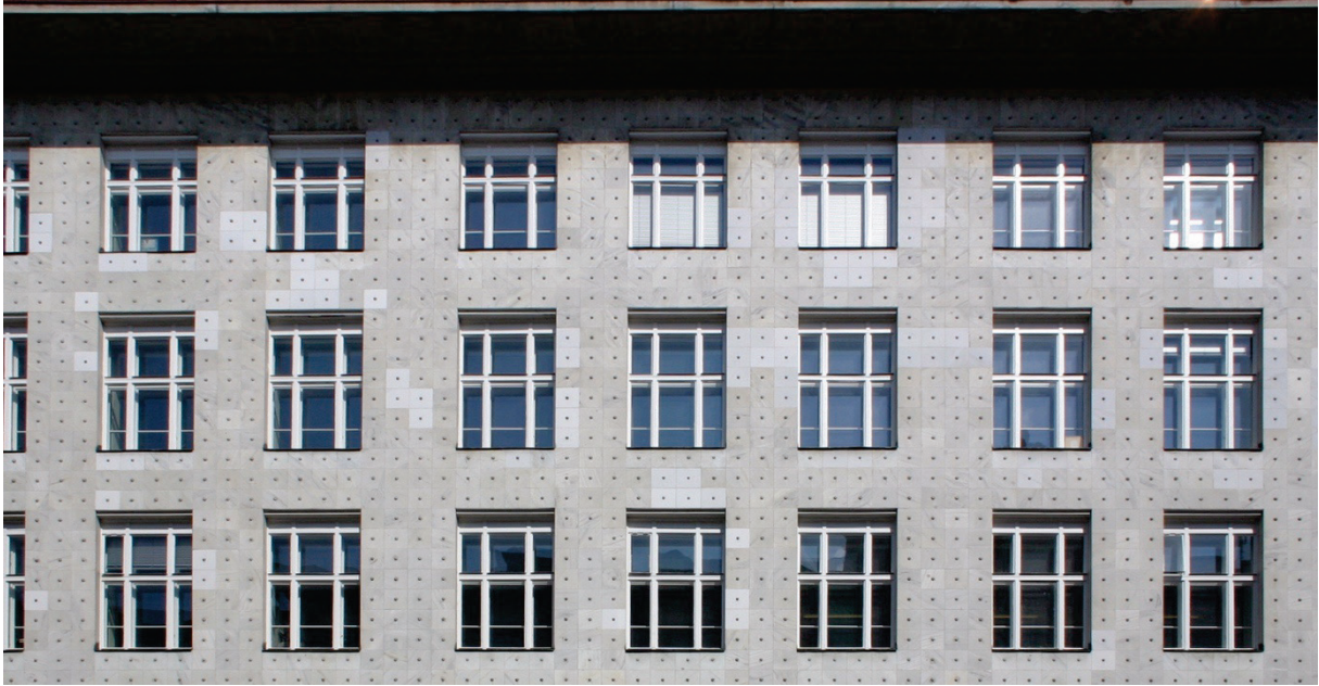
Abbildung 80: 1906, Otto Wagner, Postsparkasse, Neubau, Fassade mit Scheinnieten, Foto: Gerd Eichmann, (CC-Lizenz, Wikimedia)
