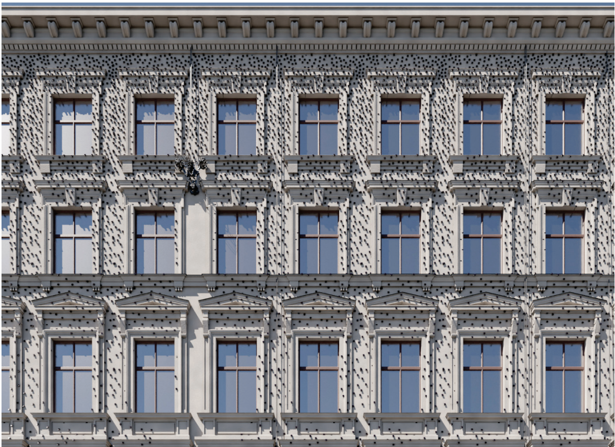
Abbildung 81: 2022, Renovierung, Fassade mit aktiven Photovoltaik-Modulen
