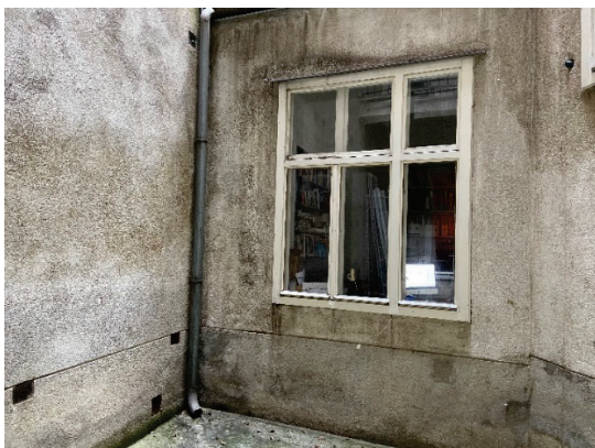
Abbildung 36: Fassade für In-Situ-Test, 1010 Wien, Parisergasse
