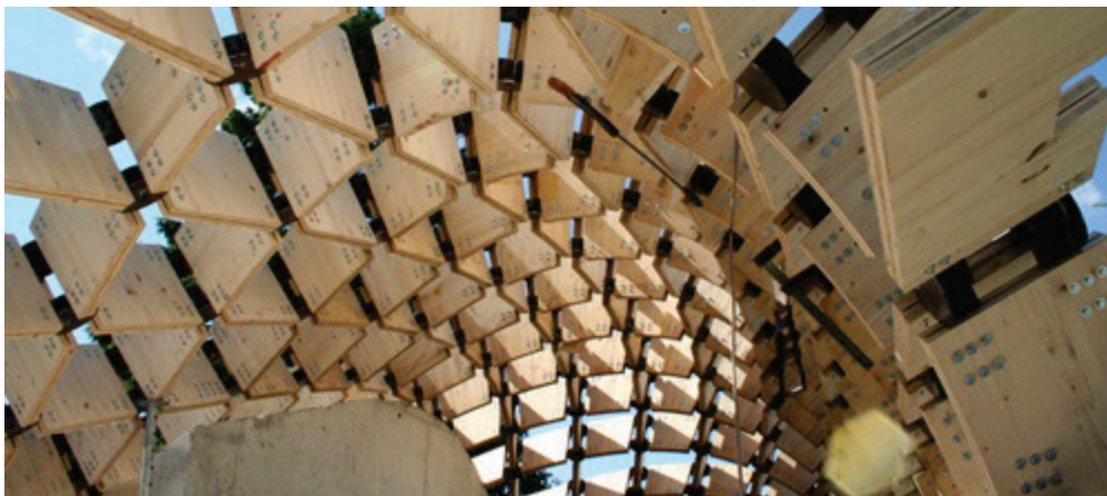
Abbildung 9: Dachkonstruktion File-to-Factory-to-site
