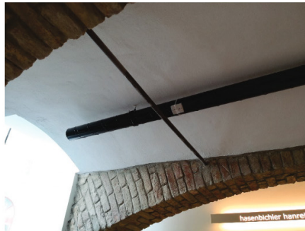
Kellermauerwerk ohne Verputz mit Wandtemperierung (links), fertige Sanierung mit Lüftungsleitung (rechts)
