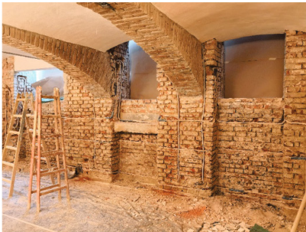
Kellermauerwerk ohne Verputz mit Wandtemperierung (links), fertige Sanierung mit Lüftungsleitung (rechts)
