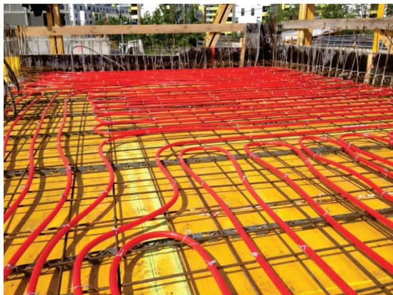
Abbildung 12: Verlegte Heizkreise in der Decke, Projekt Mühlgrund in Wien
