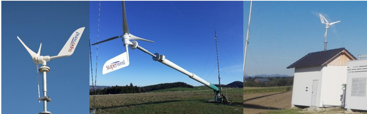
Abbildung 50: Installationspunkte Superwind 1250
