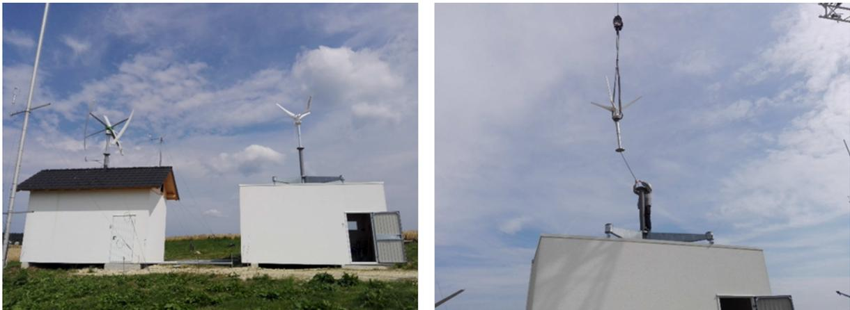
Abbildung 14: Installation Vertikon M und SuperWind 1250 auf Giebel- und Flachdach
