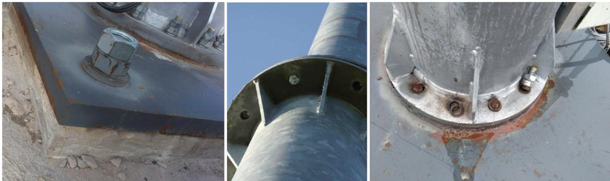
Abbildung 108: Beschädigung eines Betonfundaments aufgrund von Resonanzschwingungen (links) sowie weitere Schadensbilder aus dem Energieforschungspark Lichtenegg (Mitte und rechts)
