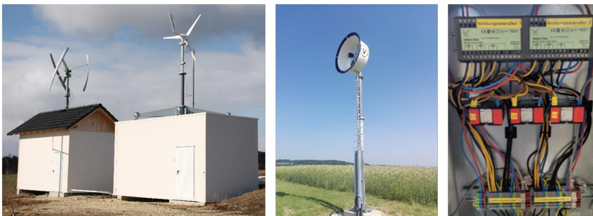
Abbildung 18: Installation Kleinwindkraftanlage und Leistungsmessung
