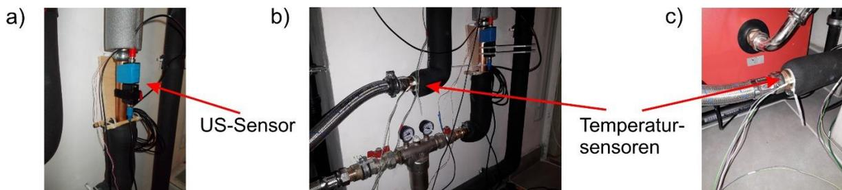
Abbildung 35: (a) An der Rücklaufleitung wird neben dem thermischen Strömungssensor auch ein Ultraschall (US)-Strömungssensor zur Referenz montiert. (b) Lage des Temperatursensors an der Vorlaufleitung zum Warmwasserspeicher (Stelle B in Abb. 33). (c) Lage des Temperatursensors an der Vorlaufleitung der Niedertemperatur-Heizung (Stelle A in Abb. 33).
