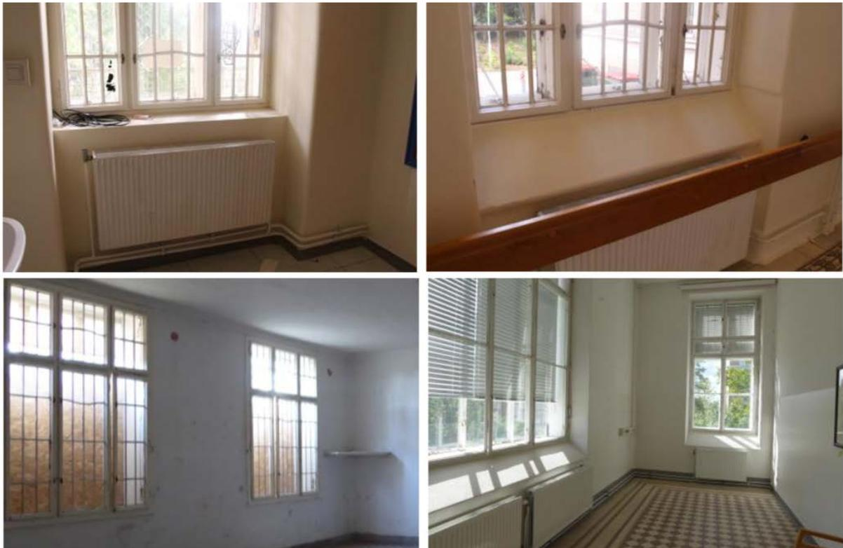
Abbildung 47: Beispiele für unterschiedliche Laibungen - Pavillon 4 (links), Pavillon 22 (rechts) (Quelle: LANG Consulting)
