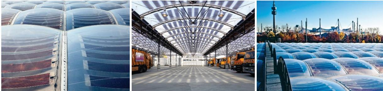
Abbildung 10: Abfallwirtschaftsbetrieb München: Die Mittellage der luftgefüllten ETFE-Folienkissen dient als Träger der flexiblen Dünnschichtsolarzellen. Im Hintergrund das Olympiastadion. Quelle: © Ackermann+Partner Architekten BDA.
