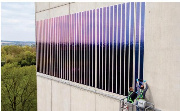
Abbildung 23: OPV-Projekt von Heliatek mit 230 m<sup>2</sup> an einem Getreidesilo, Quelle: PV-Magazin, 05/2019, <https://www.pv-magazine.de/2019/05/27/heliatek-und-lechwerke-testen-photovoltaik-folie-auf-getreidesilo/>, zuletzt geprüft am: 12.05.2020.
