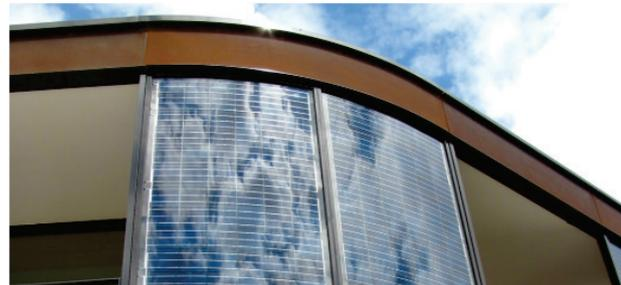
Abbildung 27: Gebogene Glas-Glas Module, Quelle: Sunovation, <https://sunovation.de/de/produkte>, zuletzt geprüft am: 12.05.202.
