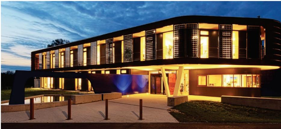
Abbildung 26: Gebäude mit transparenten Glas-Glas Modulen und zwei gebogenen Modulen, Quelle: PV-Technologies, <https://www.pvtechnologies.at/sondermodule/>, zuletzt geprüft am: 12.05.2020.
