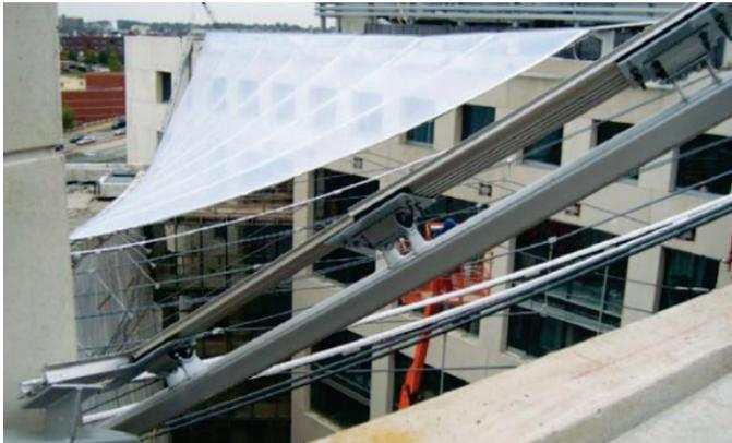
*Abbildung 31: Seilnetzkonstruktion mit ETFE-Folienkissen, Quelle, LeCuyer Annette, ETFE- Technologie und Entwurf, Basel, Boston, Berlin: Birkhäuser Verlag AG.2008.*
