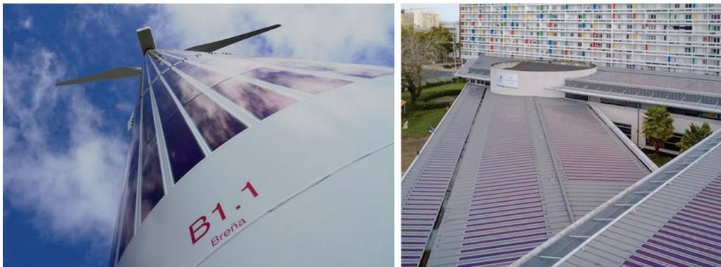
Abbildung 24: links: OPV Folien von Heliatek auf eine WKA in Spanien, Quelle: Windkraftjournal 05/2019, Acciona Energy. Rechts: OPV Anlage von Heliatek in Frankreich, Quelle: Heliatek, <https://www.heliatek.com/de/projekte/biopv-la-rochelle/>, zuletzt geprüft am: 12.05.202.
