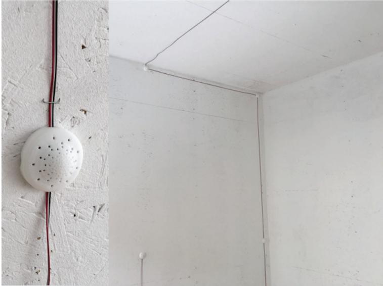
*Abbildung 22: Eigens entworfenes Gehäuse der Sensoren zur Erfassung der Oberflächentemperatur, Verteilung im Raum*
