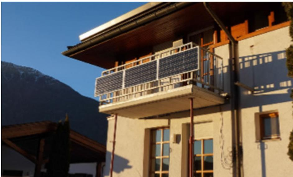
Bei der nachträglichen Anbringung von Wärmedämmungen an den Außenwänden im Zuge der thermischen Sanierung von Bestandsgebäuden stellen frei auskragende Balkone ein besonderes Problem dar. Stand der Technik bzw. gemeinhin geübte Praxis ist es entweder:
