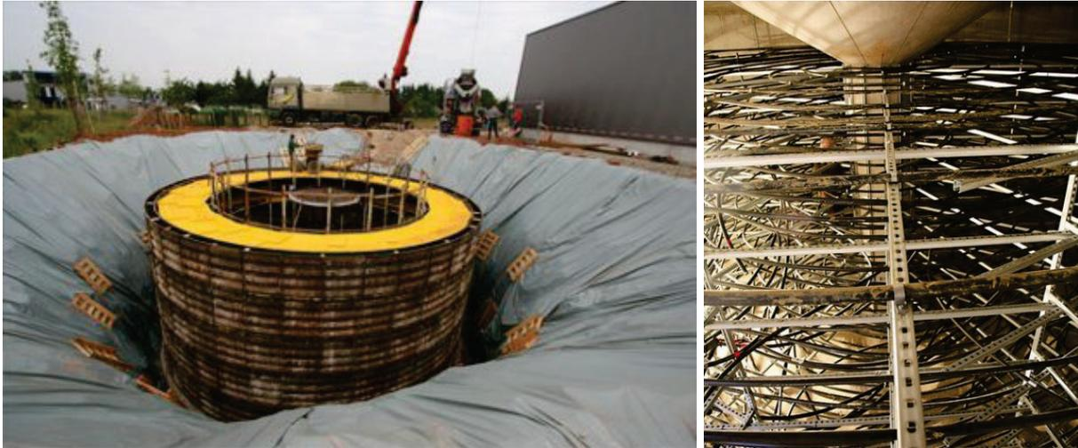
Abbildung 61: links - Eisspeicher Neustudenpark, Amriswil Einbau, rechts - Detailaufnahme Innen mit Wärmetauscherrohren<sup>38</sup>
