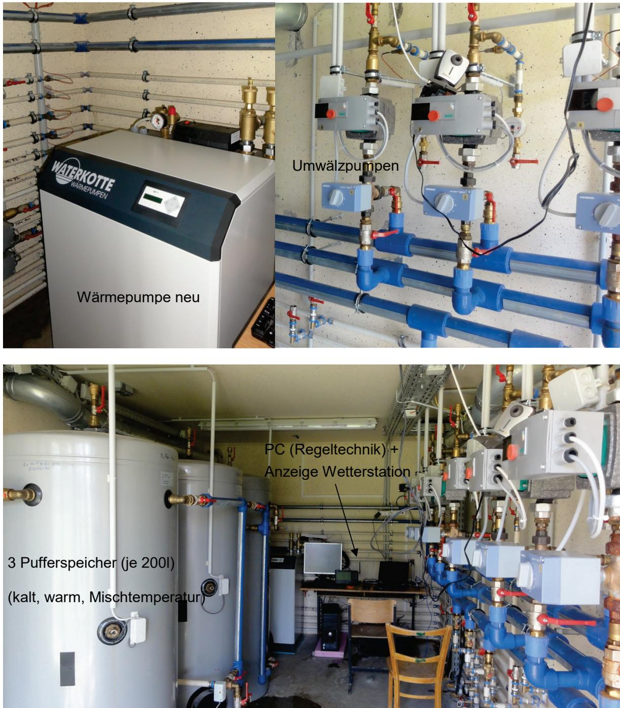
Abbildung 12: Mess-, Steuer-, Regel- und Leittechnik in der Schnauer-Garage
