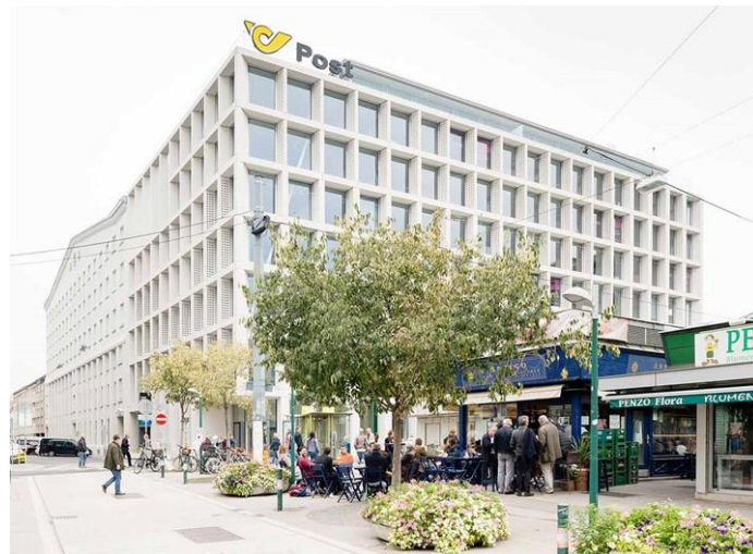
Abbildung 1: Außenansicht des Demonstrationsgebäudes „Post am Rochus“ 5 © Lukas Schaller, derstandard.at
