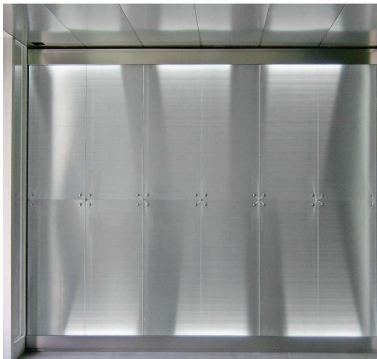
Abbildung 11: Leuchtende Wand als praktische Umsetzung eines Strukturblechs zur Lichtumlenkung
