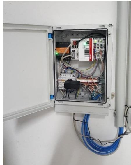
Abbildung 15 Links: Datensammler and GSM- Router an der Wand montiert; Rechts: Innenleben Datensammler, Quelle: e7
