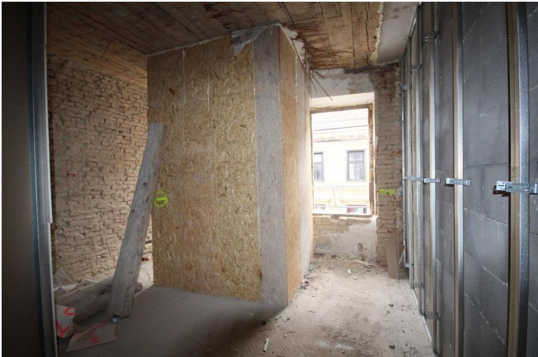
Abbildung 4 Messung im Bestand: Einhausung zur Herstellung konstanter Innenraumtemperaturen, Quelle: Trimmel Wall Architekten
