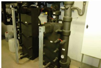
Abb. 35: Fröschl Haus: Wärmetauscher für Free Cooling; © JOANNEUM RESEARCH
