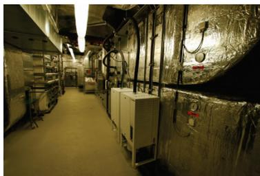
Abb. 12: IZM: Dampfbefeuchter der Lüftungsanlage; © JOANNEUM RESEARCH
