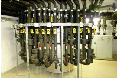
Abb. 37: Fröschl: Energieverteiler;
