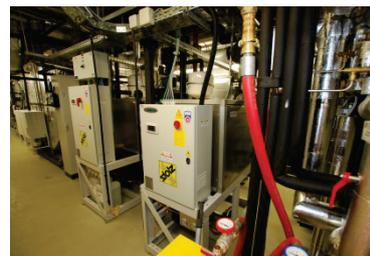
Abb. 13: IZM: Wärmepumpe und Kältemaschine; © JOANNEUM RESEARCH
