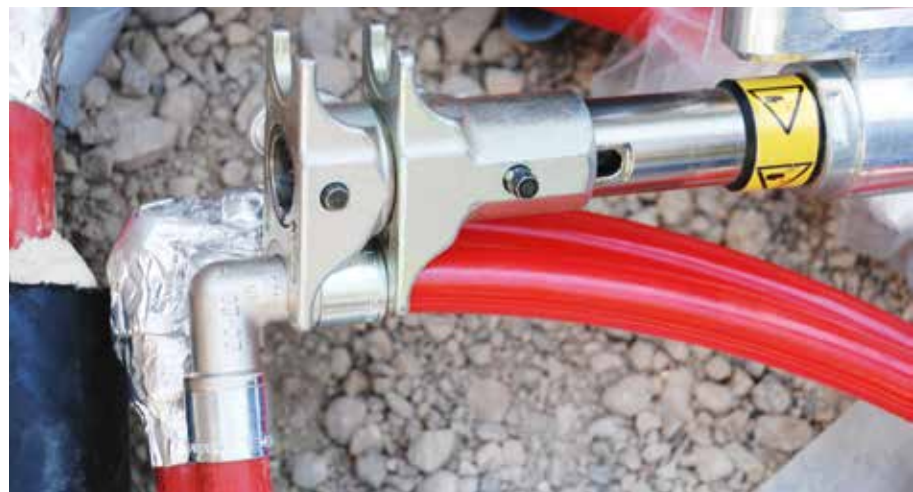
Abb. 42 | Bei Stückelungen der Rohrleitungen wird mit einer Presse eine Hülse auf die Kupplung aufgeschoben und nachträglich geschützt. © Rehau
