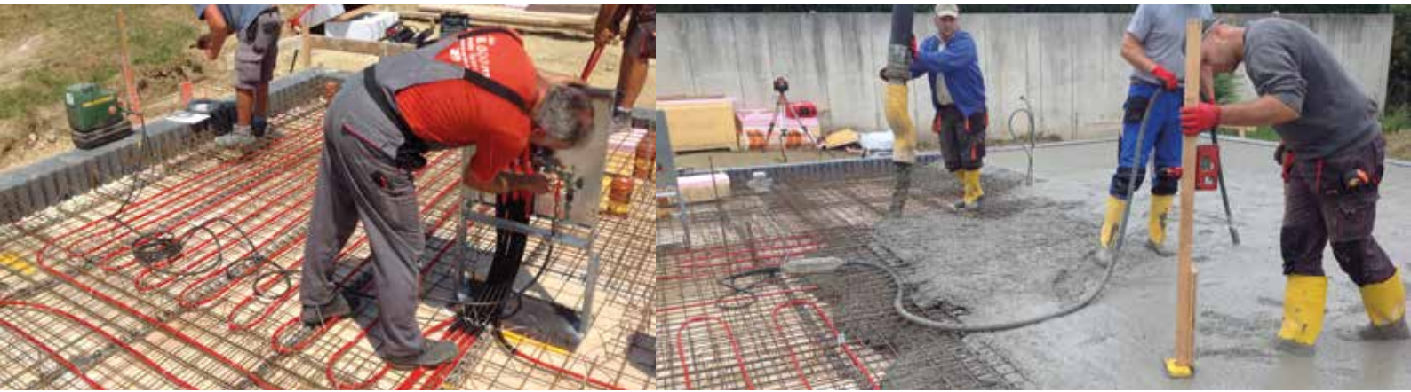
Ausführungsbeispiele der Thermischen Bauteilaktivierung: Montage der Rohrleitungen, Druckprüfung und Betonieren der Decke. © Aichinger Hoch- u. Tiefbau GmbH
