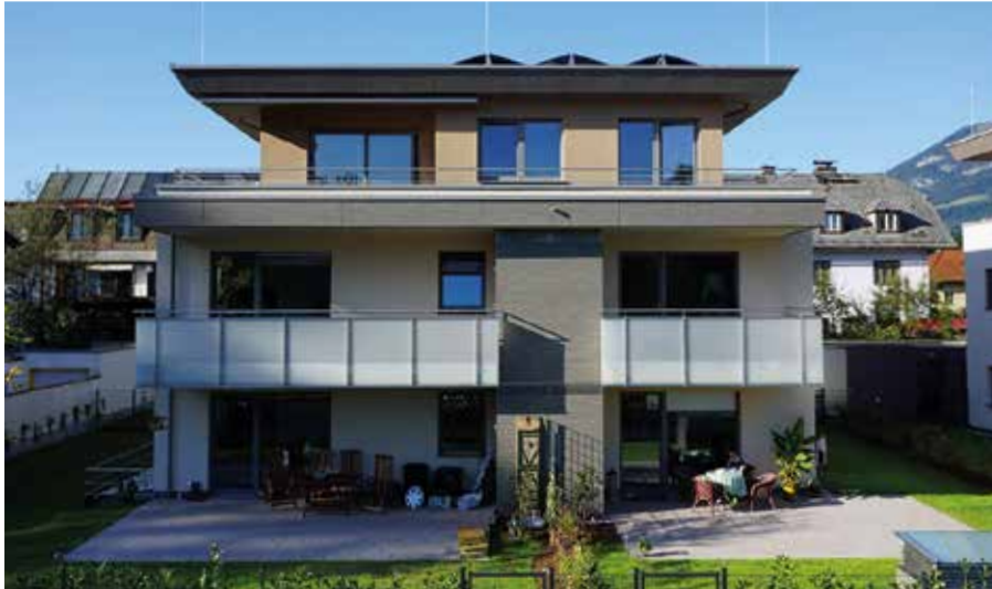
Abb. 20 | Beispiel zur Systemvariante 2 – PV-Wärmepumpe-Bauteilaktivierung, Mehrfamilienwohnhäuser Elsbethen Austrasse, Salzburg. © Michael Harrer
