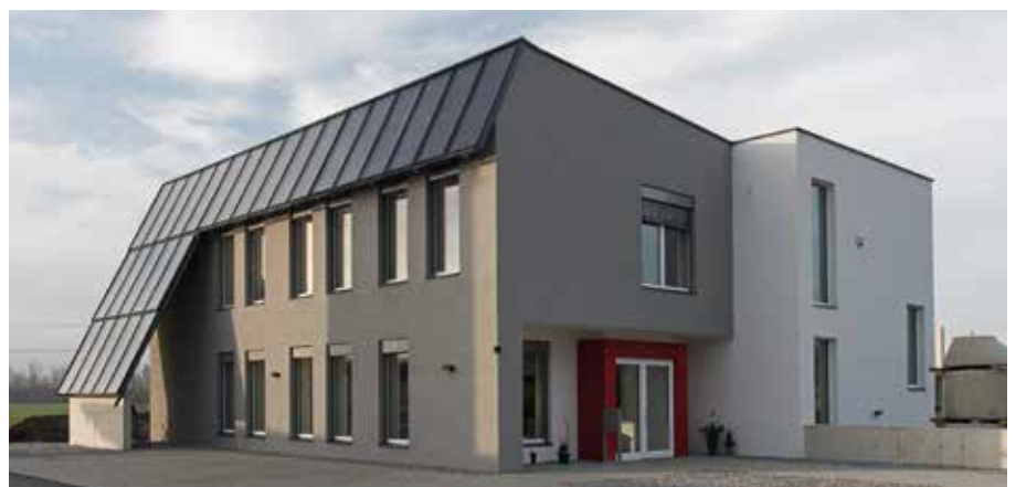
Abb. 13 | oben und rechts Solarthermische Anlage auf der Kletterhalle Saalfelden und auf dem Bürogebäude Hörfarter. © Z + B/Wild & Team; © Wolfgang Hörfarter/Hans Osterauer
