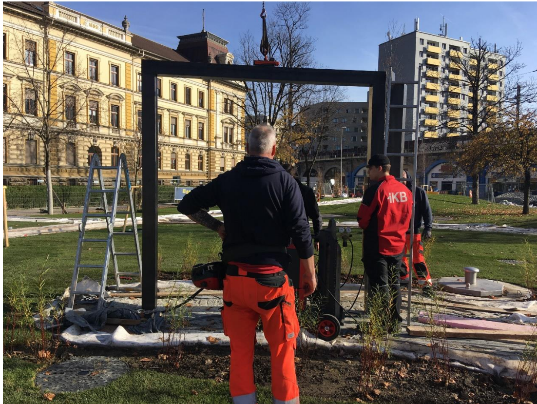
Montage Wasserwände
