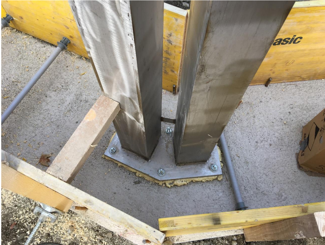
Montagefüße Wasserwände
