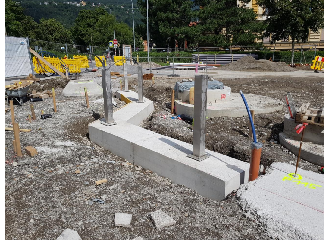
Fundament der Montagefüße für die Wasserwände
