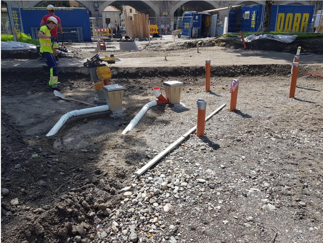
Leerrohre der Wasserdüsen, Abläufe aus dem zentralen Wasserelement
