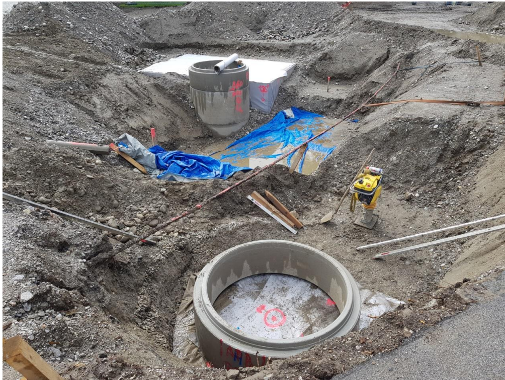
Schächte für Wasseraufbereitung
