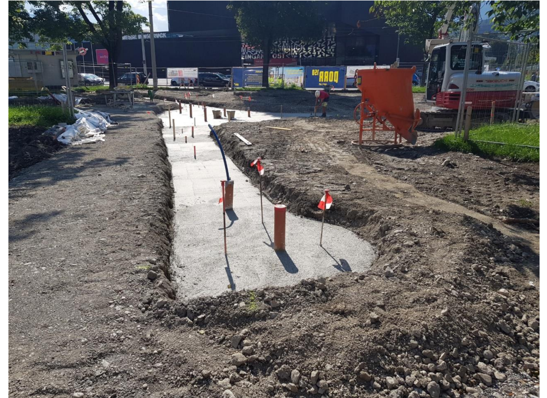
Sauberkeitsschicht Bachläufe, zentrales Wasserelement
