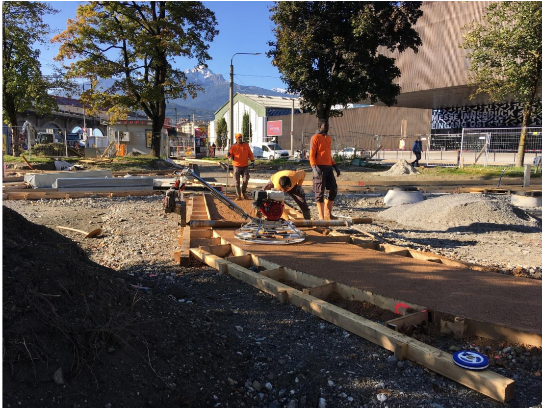
Einbau Drainbetonwege
