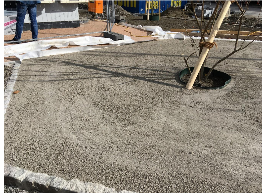
wassergebundene Wegedecke Vorplatz Trafik
