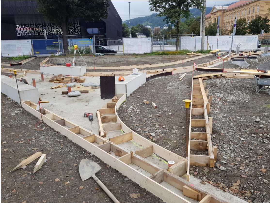
Schalung Drainbetonwege
