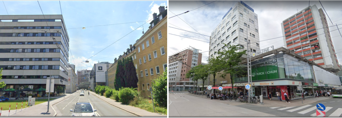
Abbildung 4: Fassadenansicht Fanny-von-Lehnert-Straße (links) und Karl-Wurmb-Straße (rechts)
