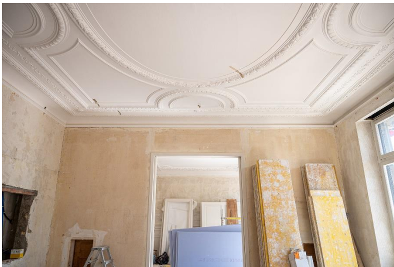
Abbildung 13: Stuckdecke im Zuge einer Wohnungsrenovierung (2)
