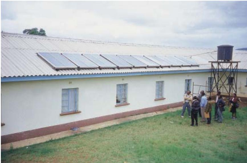
Abbildung 4: Eine der Anlagen, die an der St. Johnes Secondary School errichtet wurden. Die thermosyphonisch betriebenen Anlagen haben 20 m<sup>2</sup> Kollektorfläche und einen 1200 Liter fassenden Warmwasserspeicher.
