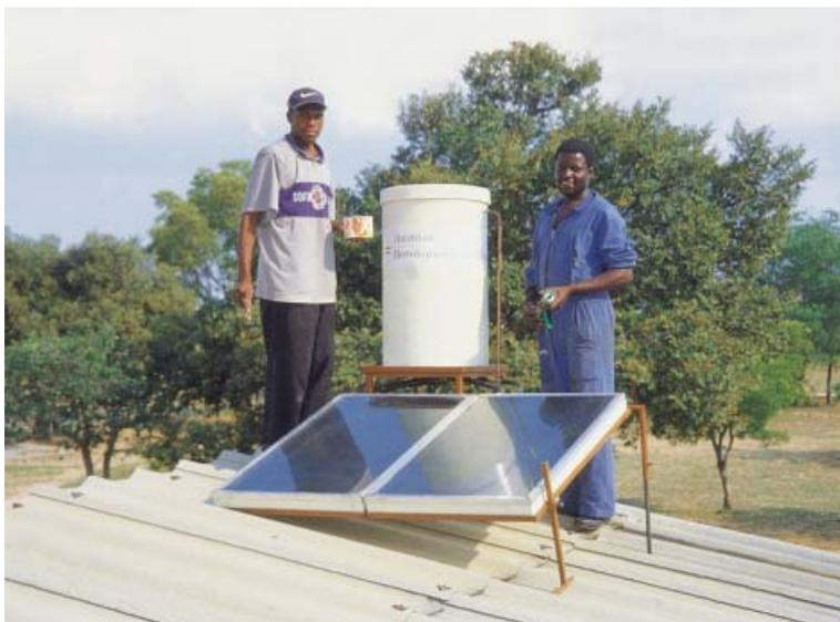
Abbildung 2: Montage einer Anlage mit 100 Liter Speichervolumen. Die vertikalen, drucklosen Speicher sind einfach zu fertigen und haben ein sehr gutes Schichtungsverhalten. Die Befüllung erfolgt über ein Schwimmerventil befüllt
