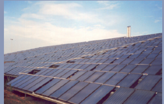
Abbildung 3: Derzeit größte Anlage zur solaren Kühlung, Griechenland (Anlagenbetreiber: SARANTIS S.A.): 2500 m 2 Kollektorfläche, 2x350 kW Adsorptionskältemaschine (Quelle: SOLE S.A. - Konstruktion und Installation)
