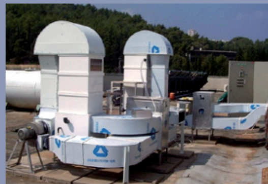
Abbildung 18: 20 kW Flüssigsorptionsanlage, Energietechnik Forschungszentrum, Haifa (Quelle: G. Grossman, Technion Haifa/Israel)
