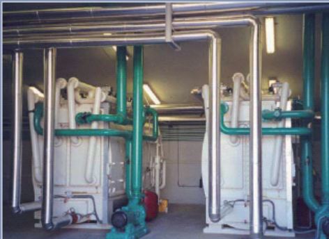
Abbildung 3: Derzeit größte Anlage zur solaren Kühlung, Griechenland (Anlagenbetreiber: SARANTIS S.A.): 2500 m 2 Kollektorfläche, 2x350 kW Adsorptionskältemaschine (Quelle: SOLE S.A. - Konstruktion und Installation)
