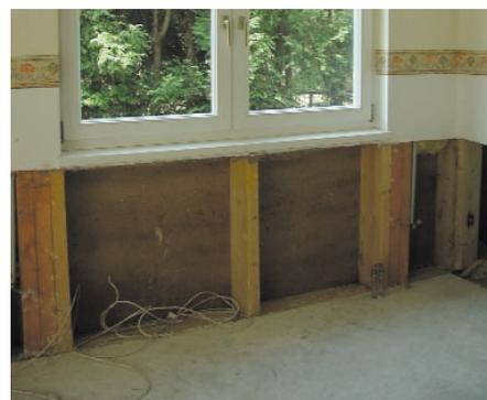
**Eine nach dem Hochwasser sofort geöffnete Konstruktion**
