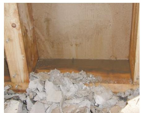
**Die Fußschwelle ist ein sensibler Bereich für Feuchtenester, Konstruktion sollte von Verunreinigungen befreit werden**
