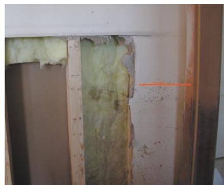
**Dämmstoff und Verkleidungsmaterial wurde ca. 30 cm über die Hochwassermarken (rote Linie) entfernt**
