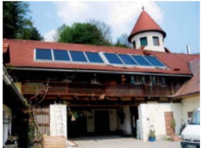
▲ Abbildung 6 Die Sonnenkollektoren versorgen den Sudkessel der Brauerei mit Wärme
