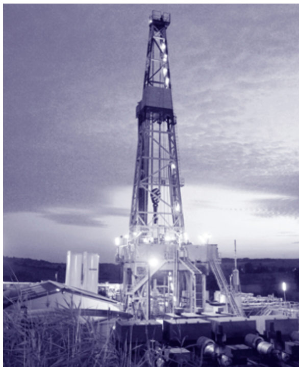
Drilling rig at the Saultz-sous-Forêts EGS site (Alsace, France).
