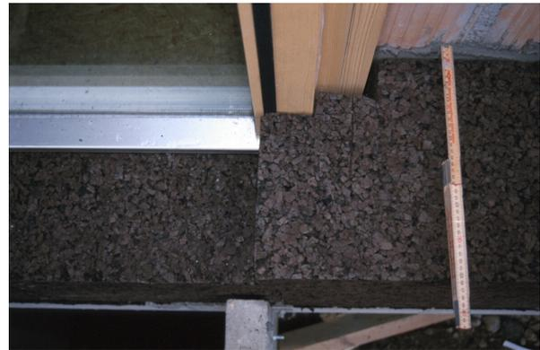
DETAIL: FENSTERRAHMEN UND KORKDÄMMUNG
