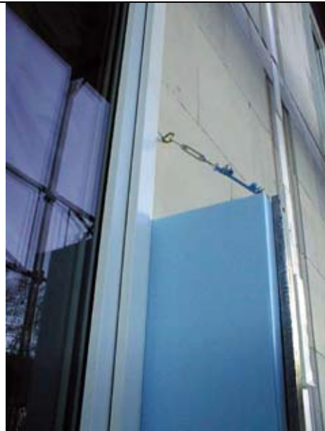
Befestigung der französ. Balkongeländer
