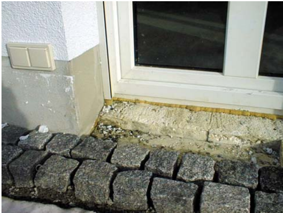
Abbildung 34: Der Fensteranschluss n der Bauphase
