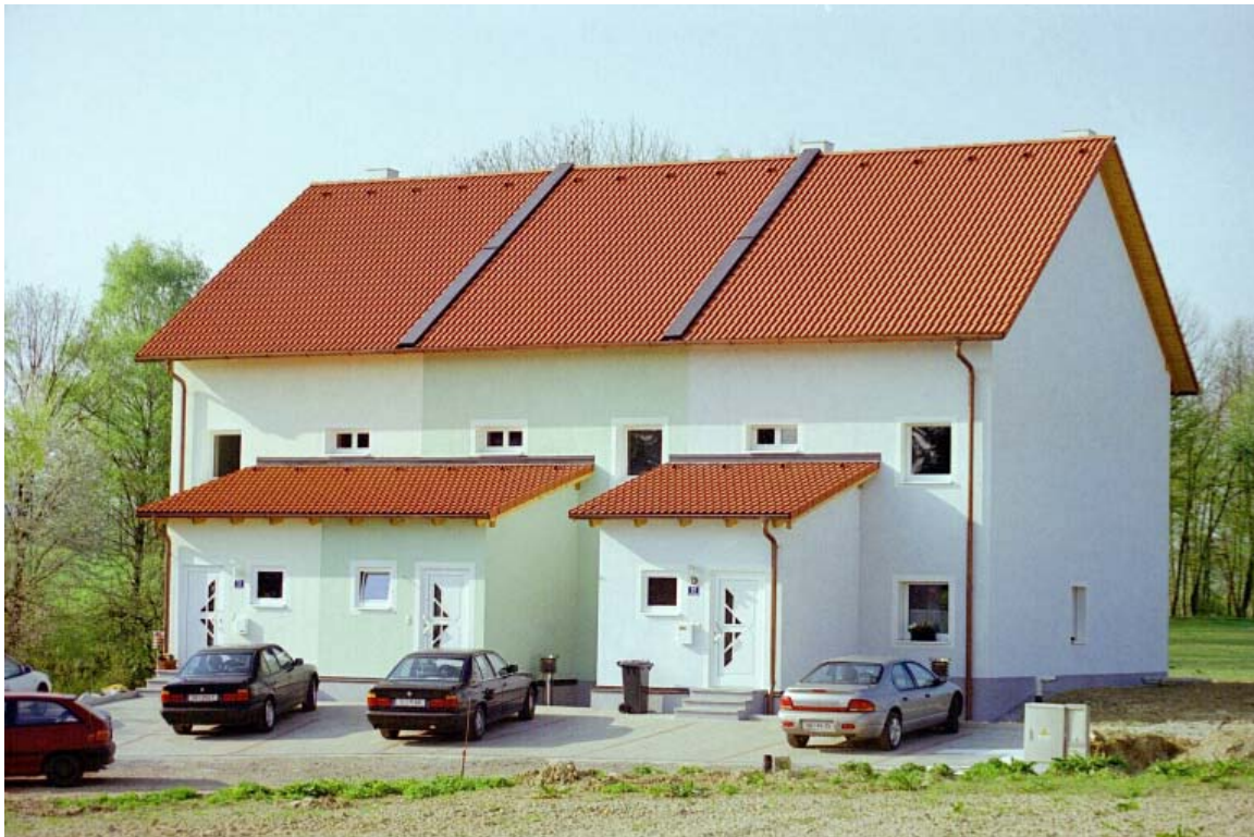
Abbildung 16: Ansicht von Nord
