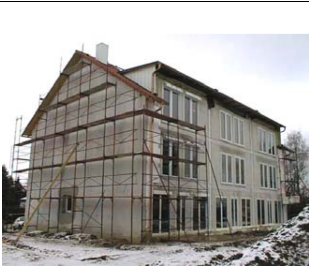
Verputzen der Fassade
