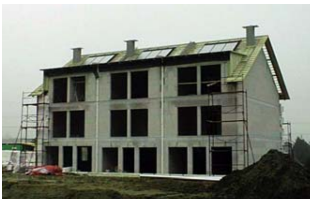
fertiger Rohbau mit Dach und Kollektoren
