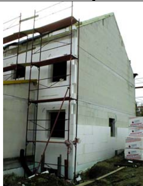
Montage der Dämmung
