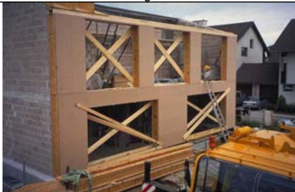
Montage der Holzleichtbauwände
