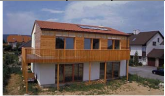
kurz vor Fertigstellung
