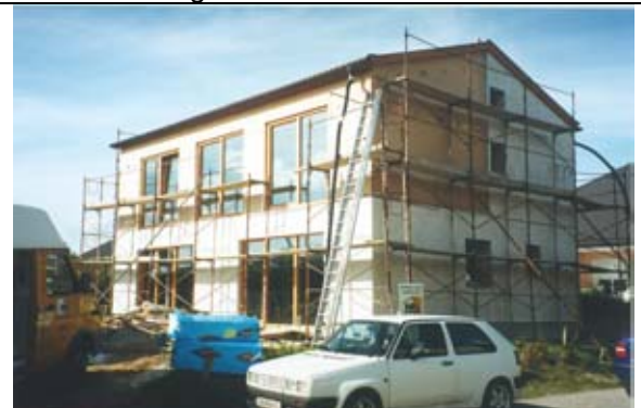
Anbringung der Fassade
