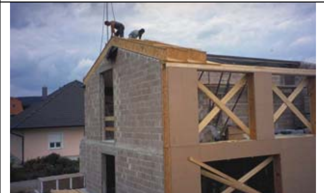
Montage der Dachträger
