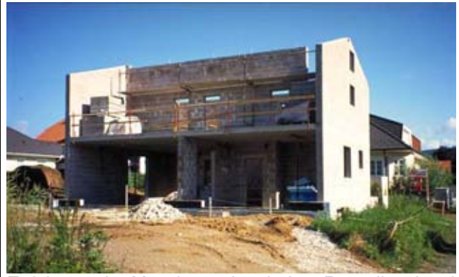
Errichtung der Massivwände mit dem Recyclingziegel
