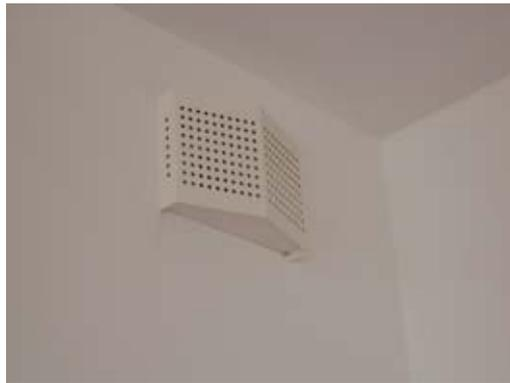
Abbildung 24: Zuluftventile - ABB Type STH
