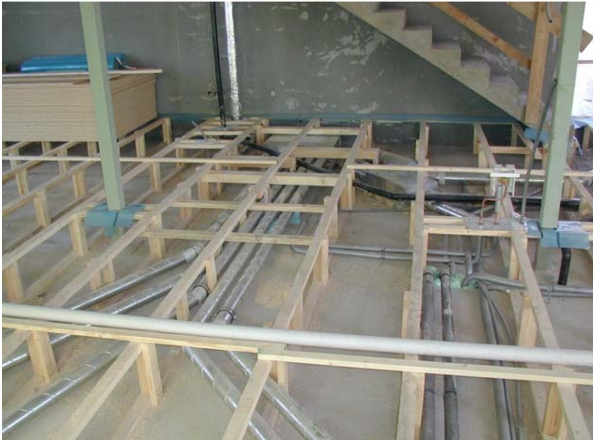
**Abbildung 23: Lüftungsrohre im Fußbodenaufbau des EG**
