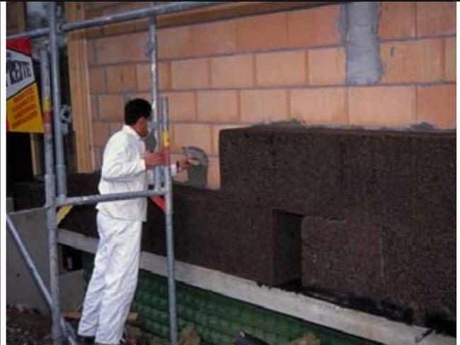
Montage der 35 cm Korkdämmung
