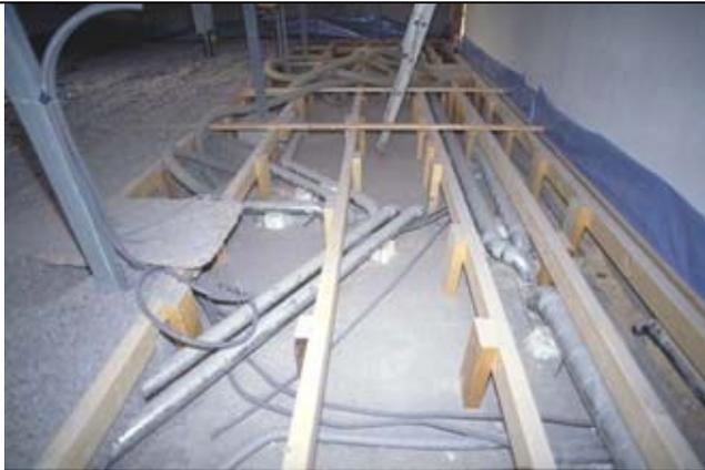
Fußbodenaufständerung, Aufnahme während des Einblasens der Zellulosedämmung
