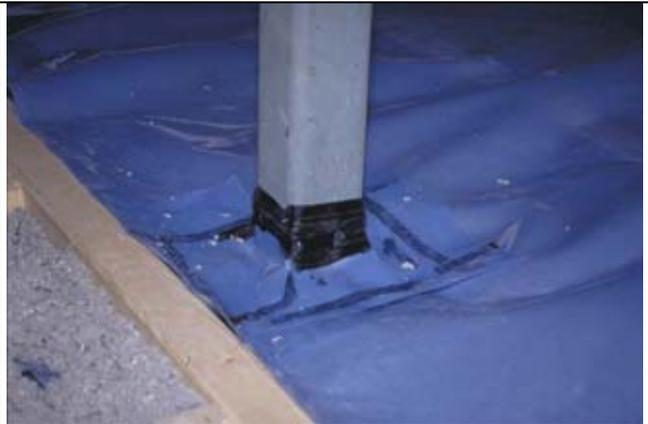
Luftdichter Abklebung der PE-Folie an den Stahlsäulen
