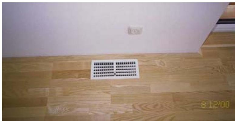
Abbildung 28: Zuluftventil am Boden
