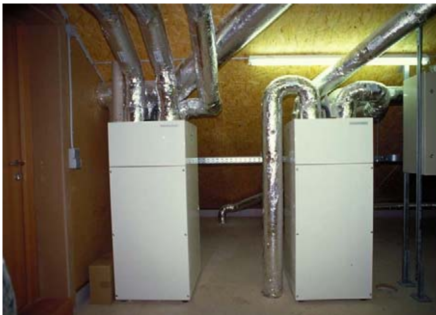
Abbildung 27: 2 AEREX-Lüftungsgeräte im Technikraum am Dachboden
