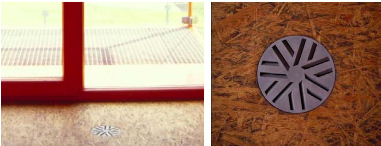
**Abbildung 17: Bodenventil zur Zuluft einbringung**
