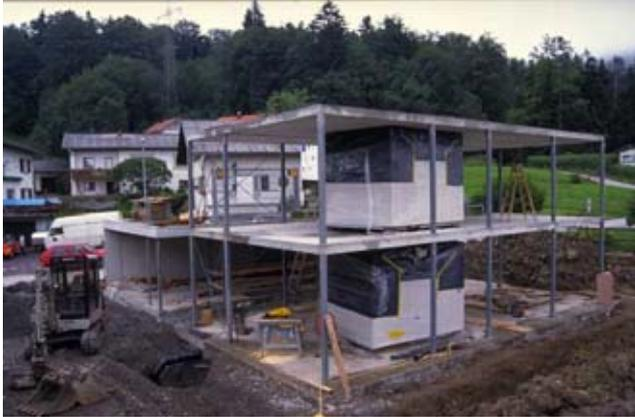
Ansicht Skelettbau mit bereits eingesetzten Sanitärzellen
