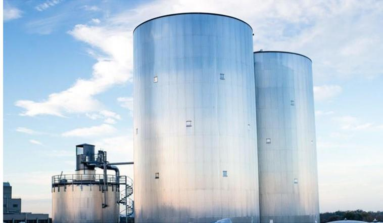
**Abbildung 30** – 11.000 m<sup>3</sup> Fernwärmespeicher der Wien Energie am Standort Simmering
