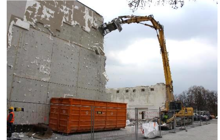
Abbildung 1: Maschineller Rückbau Wärmedämmverbundsystem
